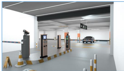
推荐方案一 机器人+道闸一体机
